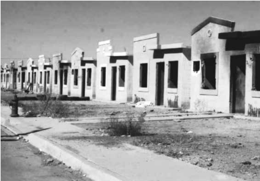
Conjunto de viviendas abandonadas producto de la violencia en el norte del país.
